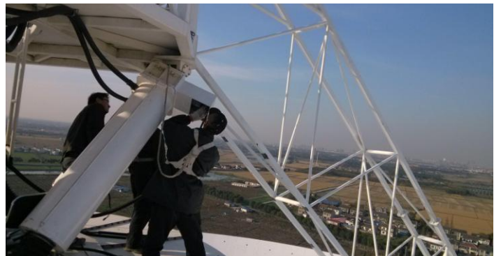
六杆并联机构安装电机罩子
